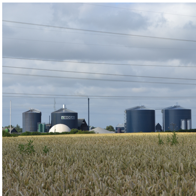
Biogasanlæg er ofte meget store og runde, og kan derfor indeholde meget.
