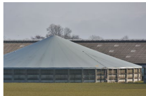
Husdyrgødning løber fra stalden via et rørsystem over i gylletanken. Mange gylletanke er overdækket med et tag. Det er med til at forhindre fordampning af kvælstof.
